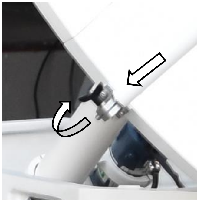
Рисунок 2.2.1.7.1 – Установка направляющих облучателя
